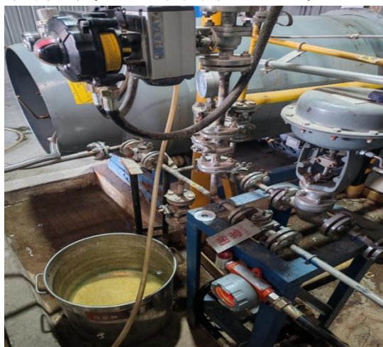
19-14 已改动探测仪安装位置，确保有毒气体探测仪距其覆盖范围内的任一释放源的水平距离不大于 2 米
