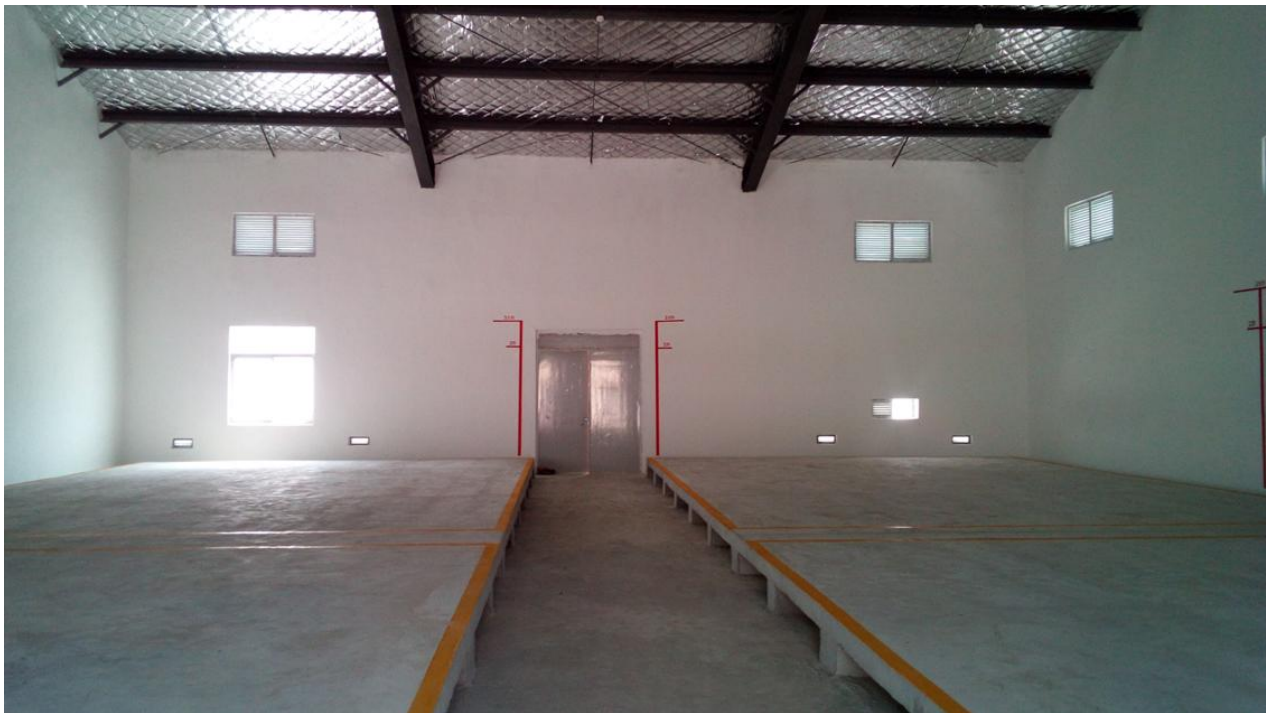
(12) 库房内已设置架空楼板防潮。
