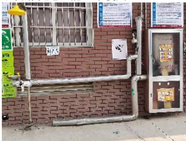
F6. 26-16 试剂库处洗眼喷淋设施已能正常使用
