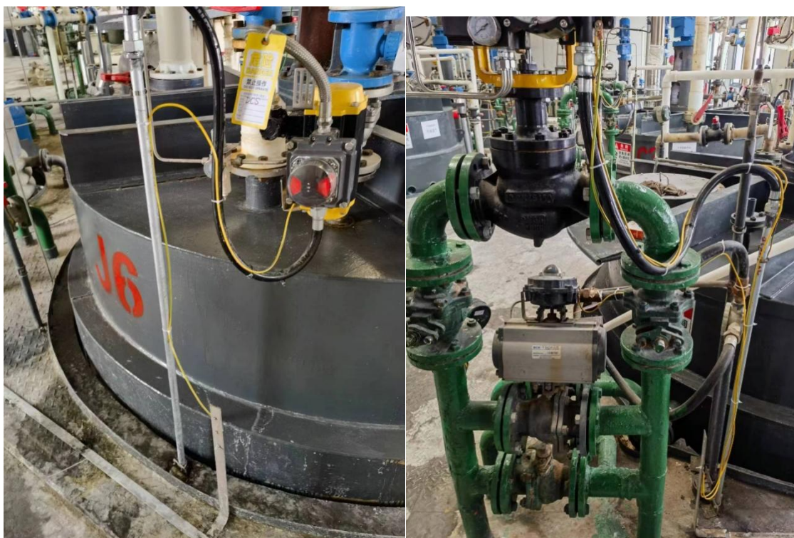
现场照片 6：电气接地接至接地网。
