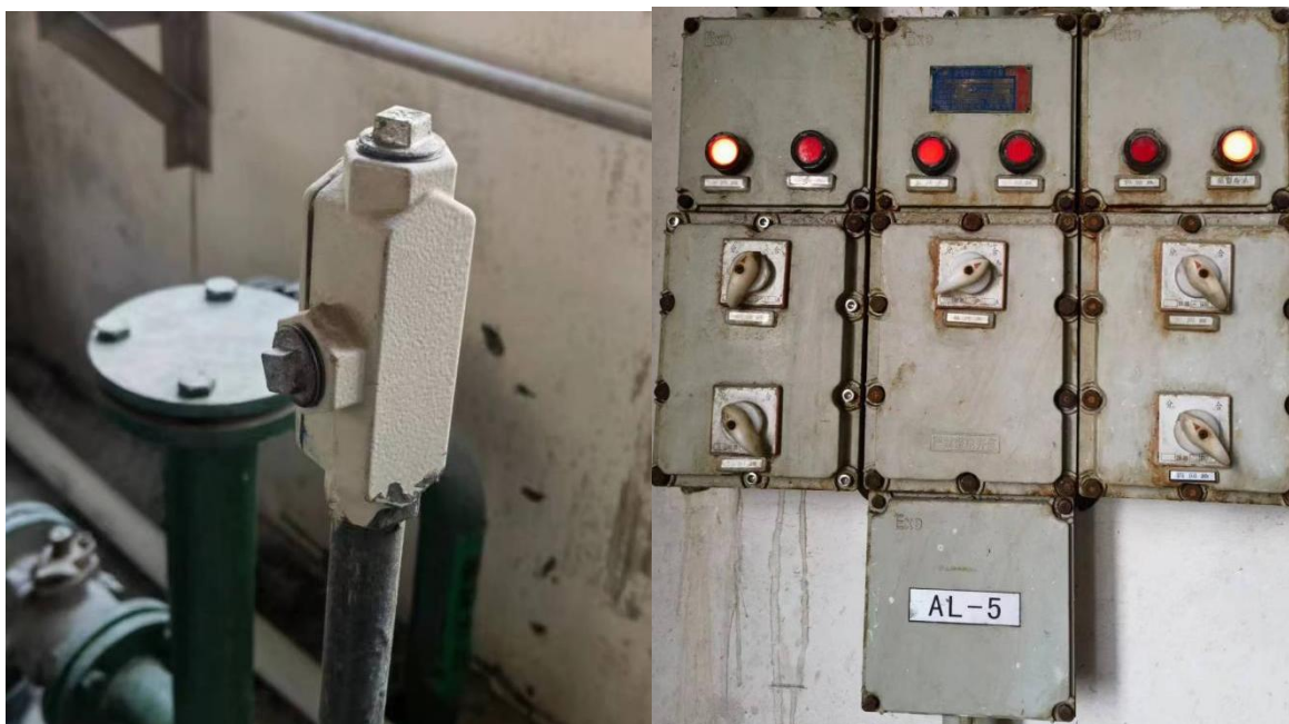
现场照片 5：生产车间一电气防爆整改情况。
