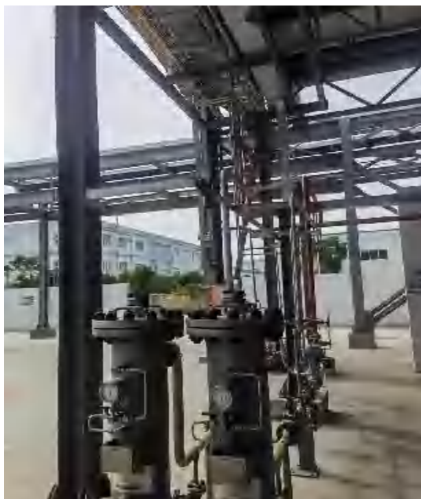
F6.32-12.氢气管线过滤器上方已增加氢气探头
