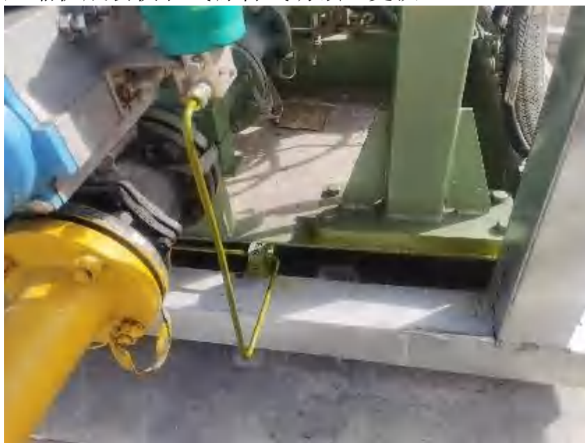
F6.32-12.氢气管线过滤器上方已增加氢气探头
