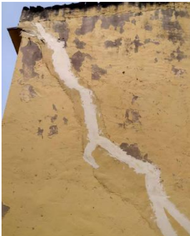
(11) 已及时维修 5 号库开裂的库房外墙
